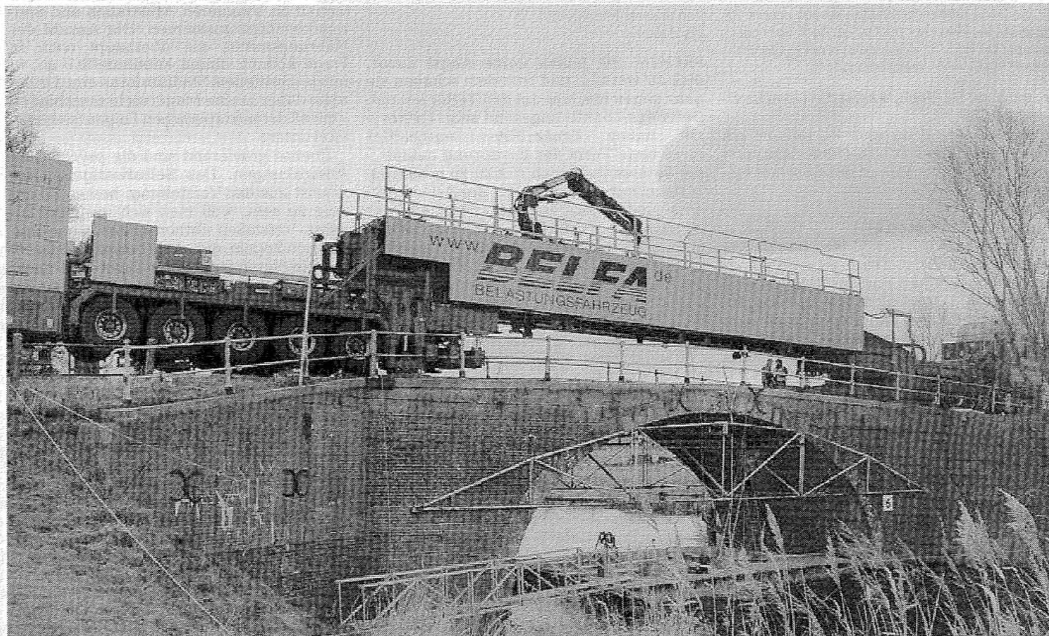
Das Belastungsfahrzeug BELFA beim Test der Gewölbebrücke in der Nähe von Groningen.
