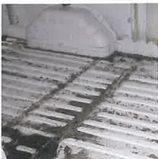
Vor der Bodensanierung ...
